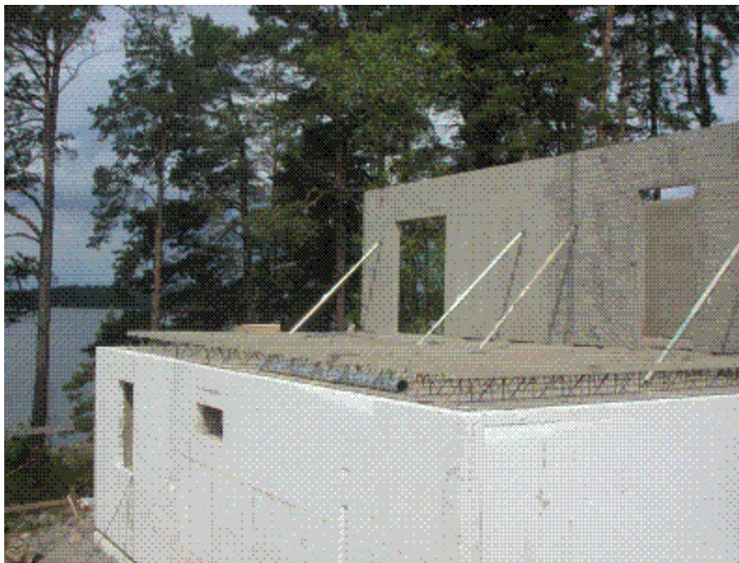
Övervåningens hjärtväggar monteras.
